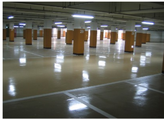
釜山 SK公寓地下停车处 (环氧地坪漆 210 适用)
